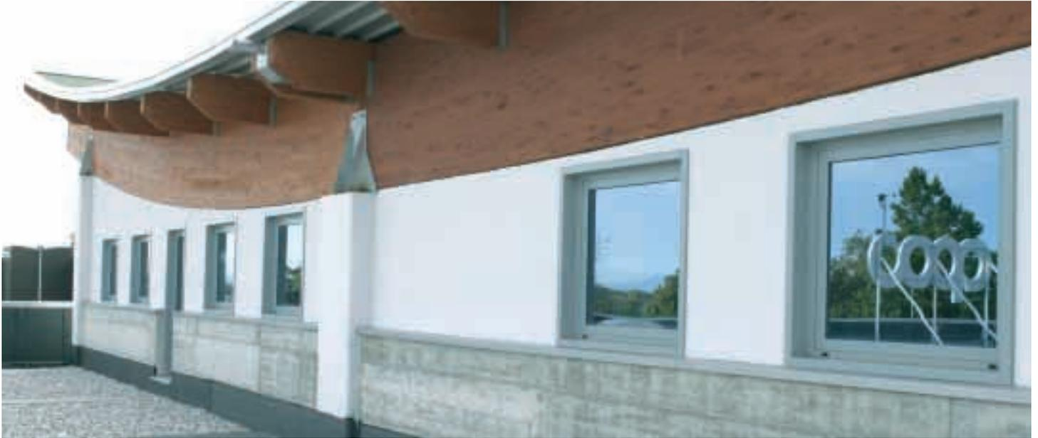
**Aquapanel Outdoor**, versione per esterni del Sistema Aquapanel di Knauf - USG, è stato impiegato per tamponare la facciata del nuovo **Centro Commerciale di Cervignano del Friuli**, opera degli Arch. Rudy Lepre e Giuseppe Garbin.
